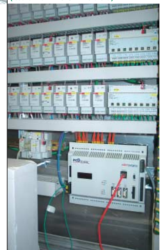
Bild 3: Lösungen der komplexen Steuer- und Regelaufgaben mit der Kombination Saia SPS PCD2 und EIB-Komponenten. (Quelle: BUS-House)
