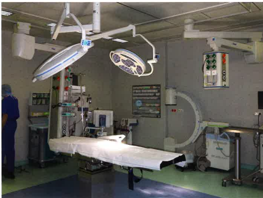
Moderner OP mit TAV-Differenzialflow und kurzen Schürzen (Bildquelle HSLU).
