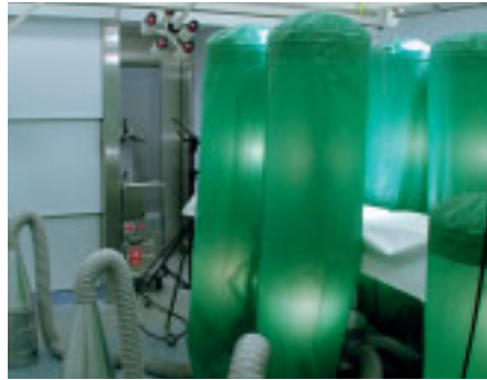
Abb. 2: Musterlastanordnung: OP-Qualifizierung GZO-Spital Wetzikon. Unter dem OP-Tisch ist der Verteiler für die Referenzlast sichtbar. Die Luftprobe für die Messung der Partikelkonzentration wird diesem Verteiler entnommen. Im Vordergrund die Luftgeschwindigkeitsmessung zur Ermittlung des Volumenstroms. Diese Aufnahme wurde im Rahmen einer Diplomarbeit gemacht. Es galt den Einfluss verschiedener Auslassgrößen auf den Schutzgrad zu ermitteln.
