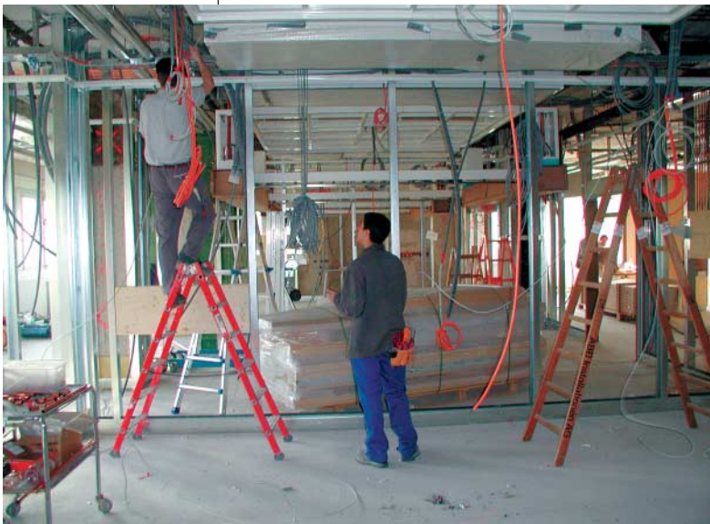
Bild 5: Abtrennung der OP-Säle durch Leichtbauwände, an der Decke sichtbar die TAV-Decken und die umfangreichen Installationen. (Foto: BUS-House)
