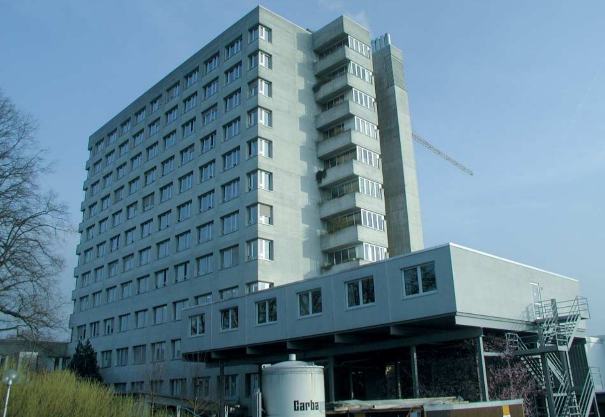
Bild 1: Blick auf das Hochhaus des Spitals mit dem Provisorium im Vordergrund. (Foto: BUS-House)
